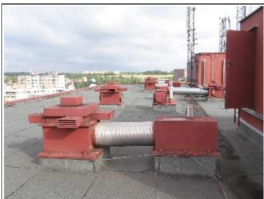
Pohled na střechu
