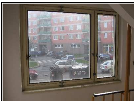
Okno na schodišti
